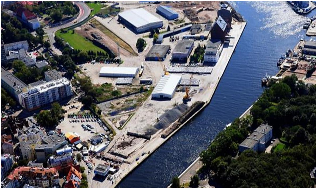
Rys. nr 3: Widok na teren planowanej inwestycji
