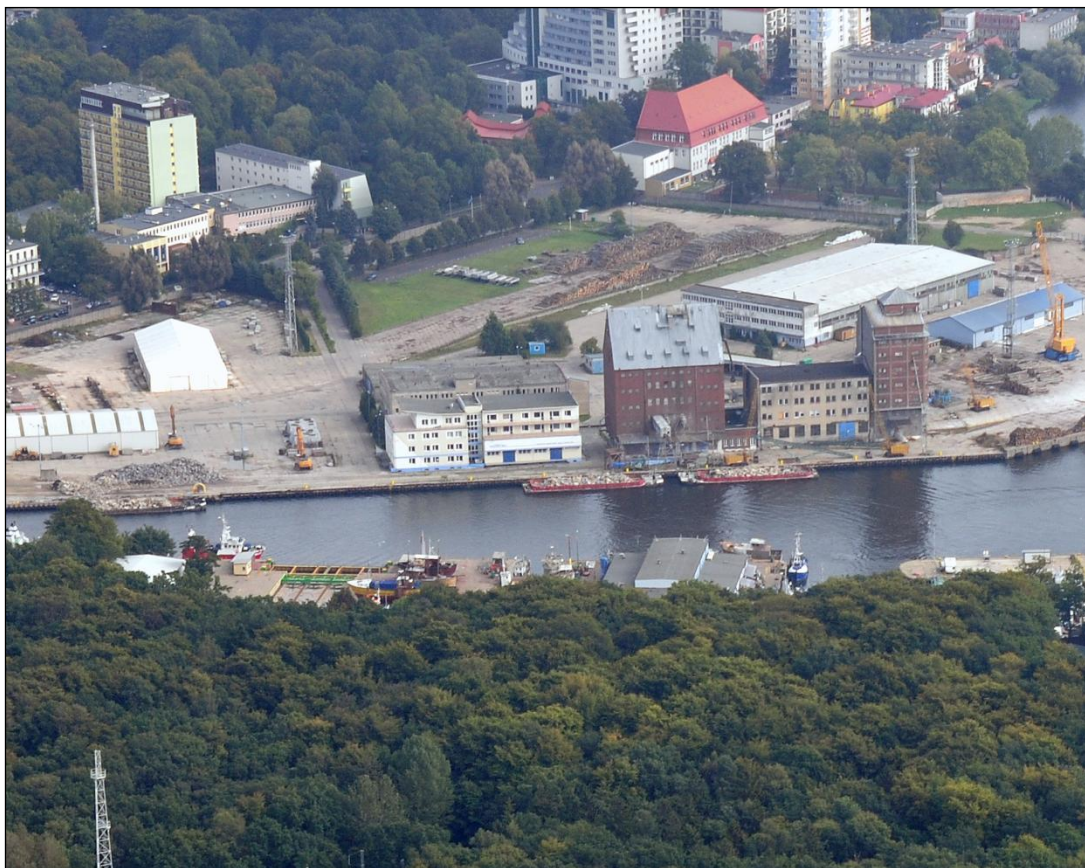
Fot. 1. Teren Nabrzeża Zbożowego w Kołobrzegu
